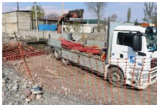
Фотография 8: Участок строительства огорожен, Май 2021 года
