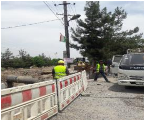
Фотография 3: Стройплощадка должным образом огорожена, 2021 года
