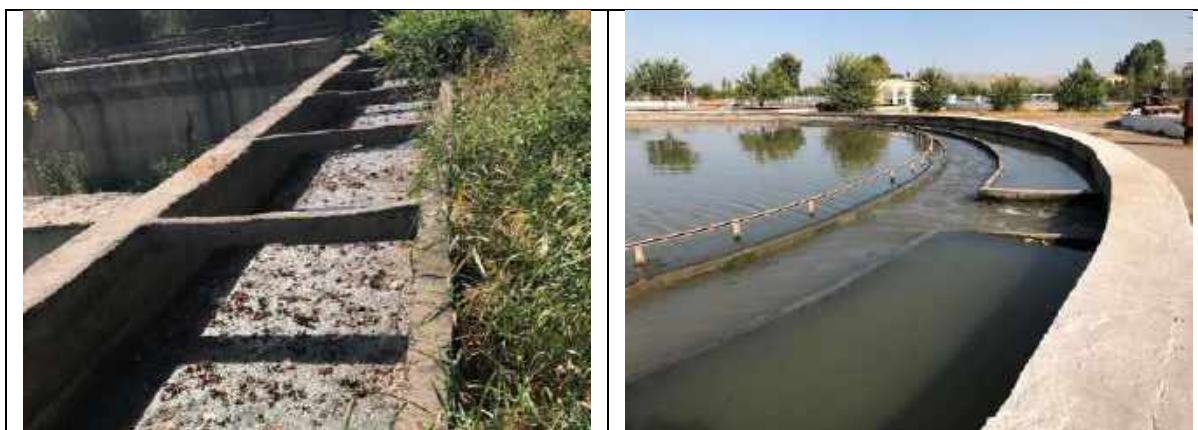
Табличка 5: Станция очистки сточных вод
