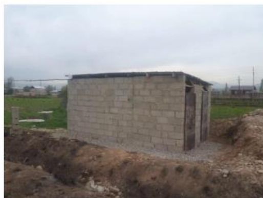
Фото 2: Обустроены дополнительные туалеты для рабочих
