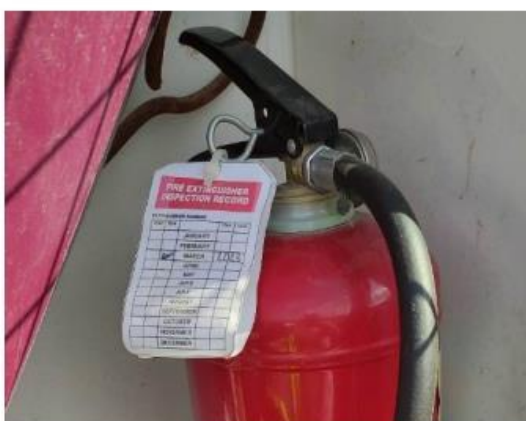
Фото 5: Проверка и маркировка огнетушителей
