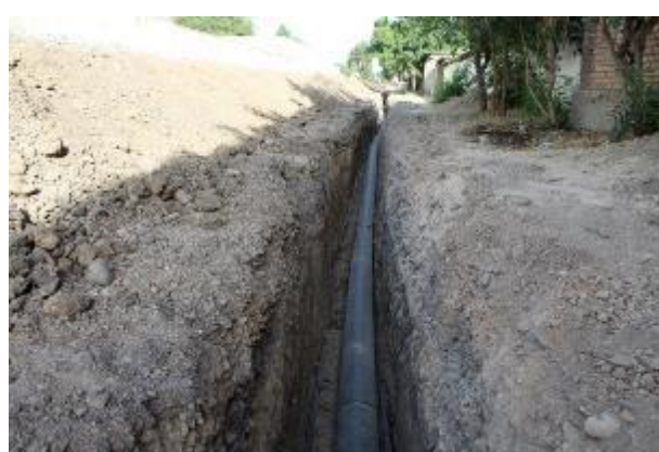
Фото 23: Прокладка трубопровода, 15 июня 2023 г.
