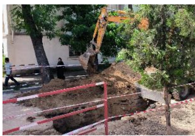
Фото 18: Земляные работы, установка жестких ограждений, 03 мая 202 г. 3
