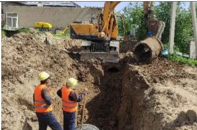
Фото 1: Раскопка траншеи и подготовка основания для укладки трубы, 04 апреля 2023 г.
