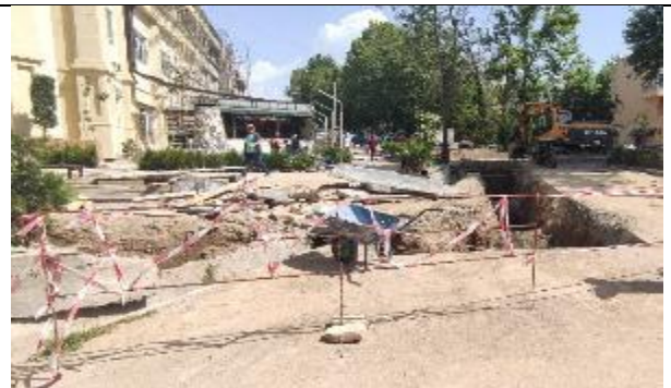
Фото 30: CW01 участок 2 - улучшенное ограждение траншей подрядчиком
