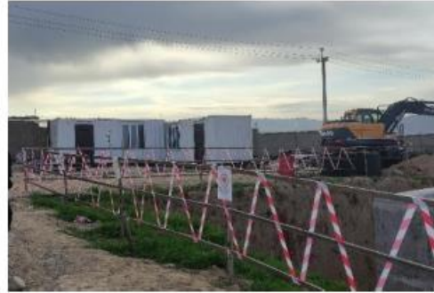
Фото 8: Установлены предупреждающие знаки и жесткие ограждения вокруг вырытых траншей
