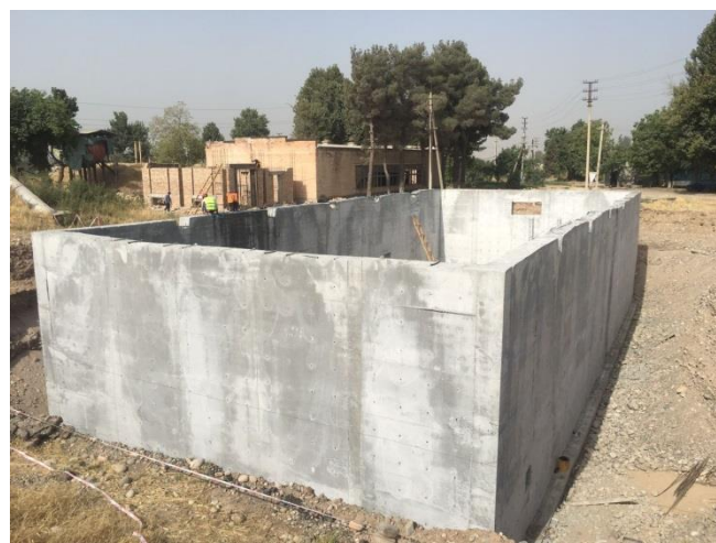
Фото 12: Работы по бетонированию насосной станции 01 июня 2023 г.
