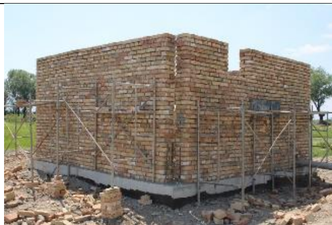
Фото 9: Кирпичная кладка здания колодца, 20 апреля 2023 г.
