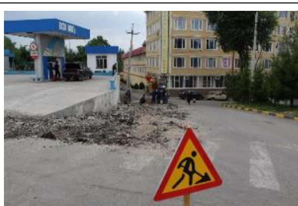
Фото 22: Снятие асфальта, установка предупреждающих знаков, 25 мая 2023 г.
