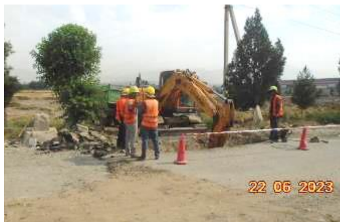
Фото 3: Раскопки для подключения к главному коллектору, 22 июня 2023 г.
