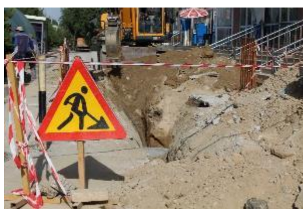
Фото 24: Работы по обратной засыпке, информационные знаки установлены 15 июня 2023 г.
