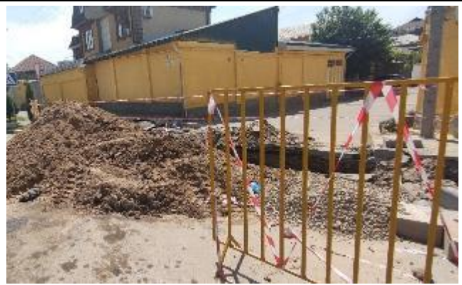
Фото 26: CW-04 участок 1 Установлены барьеры и сигнальная лента
