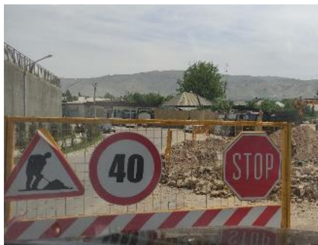
Фото 16: Установка дорожных знаков, 01 июня 2023 г.
