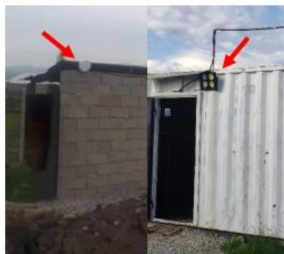
Фото 4: Установлены дополнительные осветительные приборы
