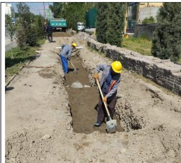
Фото 13: Ручная засыпка, 27 апреля 2023 г.
