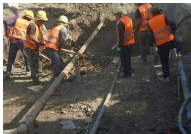
Фото 4: Земляные работы в районе существующего участка коммуникаций К50-К45, 06 июля 2022 г.
