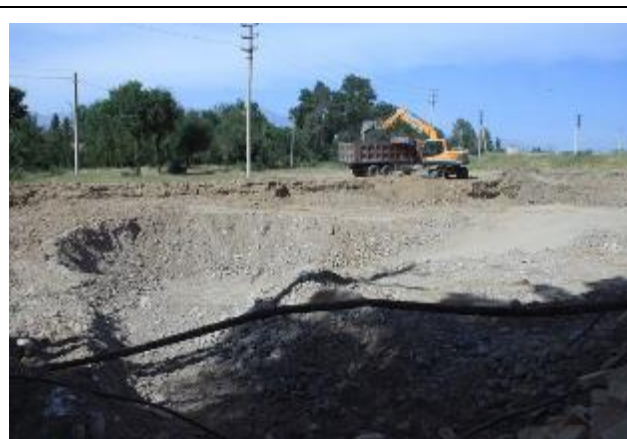
Фото 10: Выемка грунта под насосную станцию, 11 мая 2023 г.
