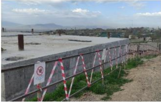
Фото 7: Установлены предупреждающие знаки и жесткие ограждения вокруг вырытых траншей
