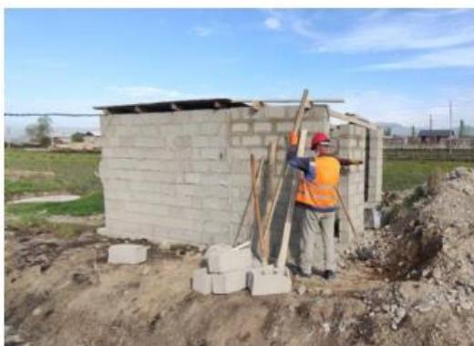
Фото 1: Строительство дополнительных туалетов
