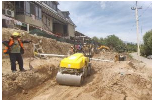
Фото 2: Уплотнение грунта К50-К39, 05 мая 2023 г.
