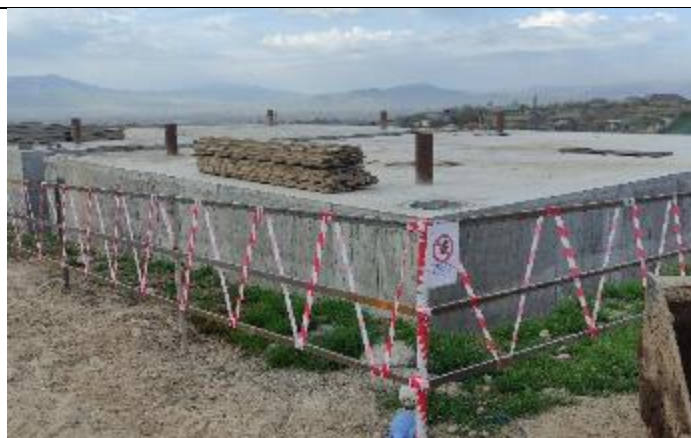
Фото 5: Строительство водохранилищ в Ховароне, жесткое ограждение установлено 18 марта 2023 г.
