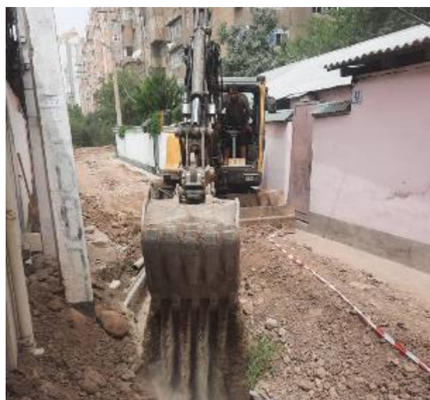
Фото 20: Обратная засыпка траншей, 22 июня 2023 г.
