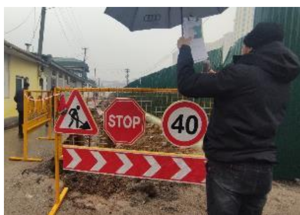
Фото 17: Установка дорожных знаков, 15 февраля 2023 г.
