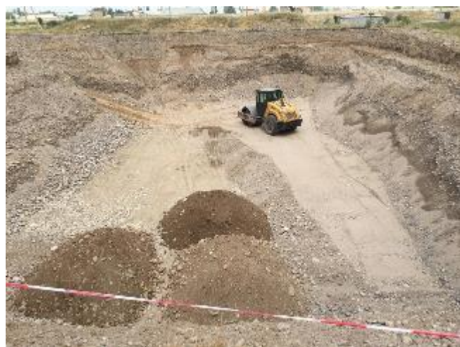
Фото 11: Котлован насосной станции, 25 мая 2023 г.
