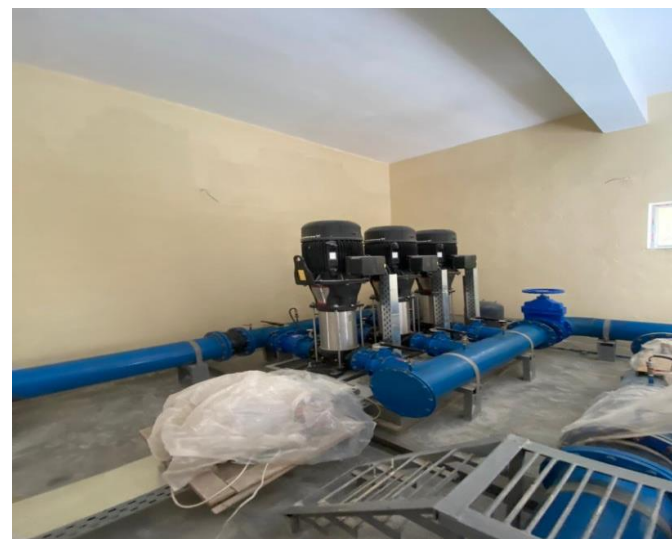
Фото 8: Строительство Ховаронской насосной станции, 5 мая 2023 г.
