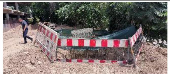
Фото 32: CW-03 Лот 2 Установлены защитные ограждения
