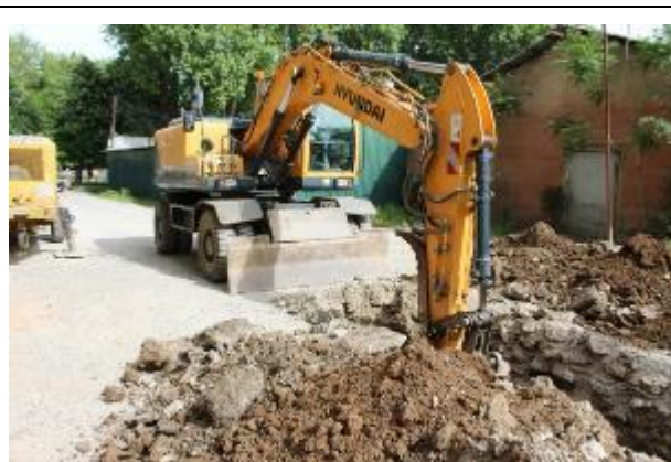
Фото 21: Раскопки траншей, 20 апреля 2023 г.
