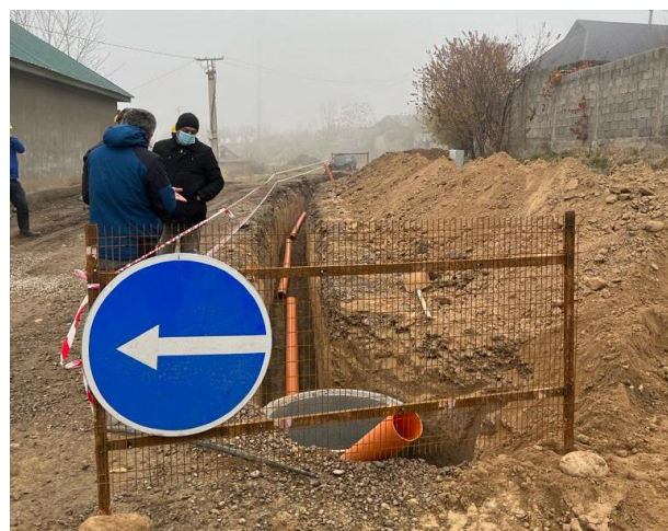
Фото 4: Установка ПВХ труб, декабрь 2023.4
