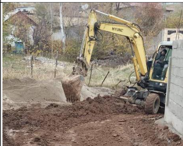
Фото 8: Засыпка траншеи, 8 Ноябрь 2023 года
