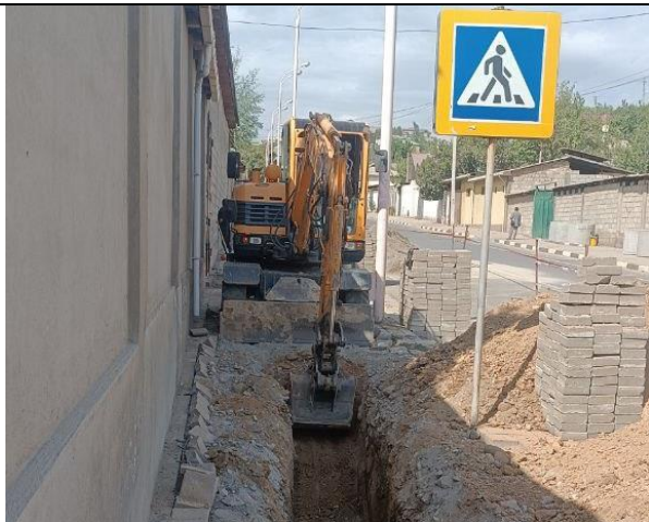
Фото 1: Раскопка траншеи, август 2023.1
