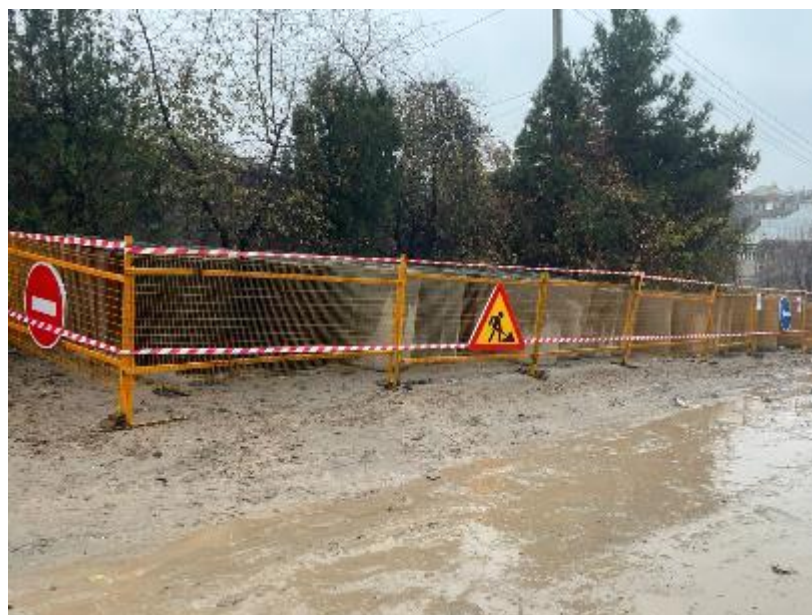
Фото 18: Кольца колодцев собраны в одну зону и зона хранения огорожена жесткими ограждениями
