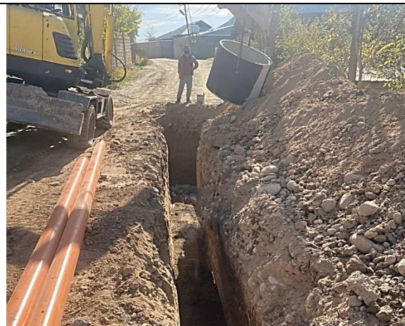
Фото 6: Установка железобетонных канализационных колодцев, октябрь 2023 года
