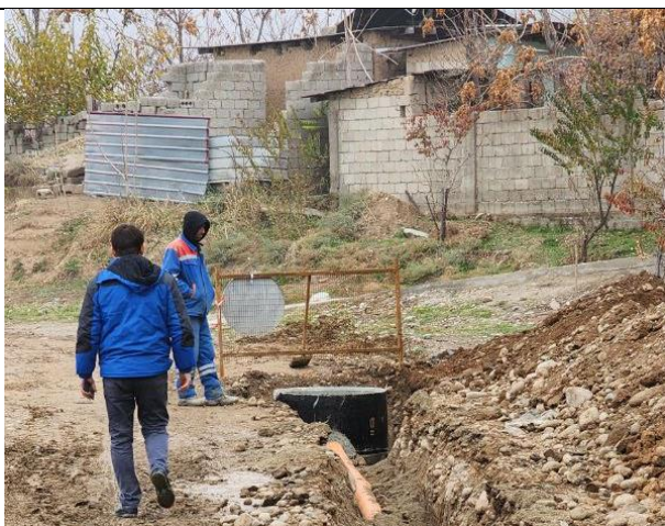
Фото 7: Установка труб UPVC, 7 Ноябрь 2023 года
