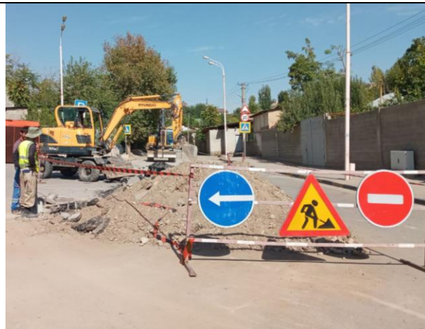
Фото 2: Раскопка траншеи, август 2023.2
