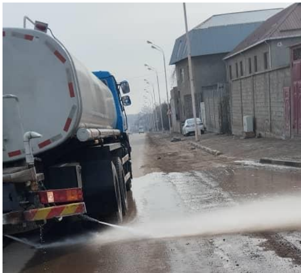
Фото 11: Согласно плану, подрядчик поливал улицы для уменьшения пыли, сентябрь 2023 года
