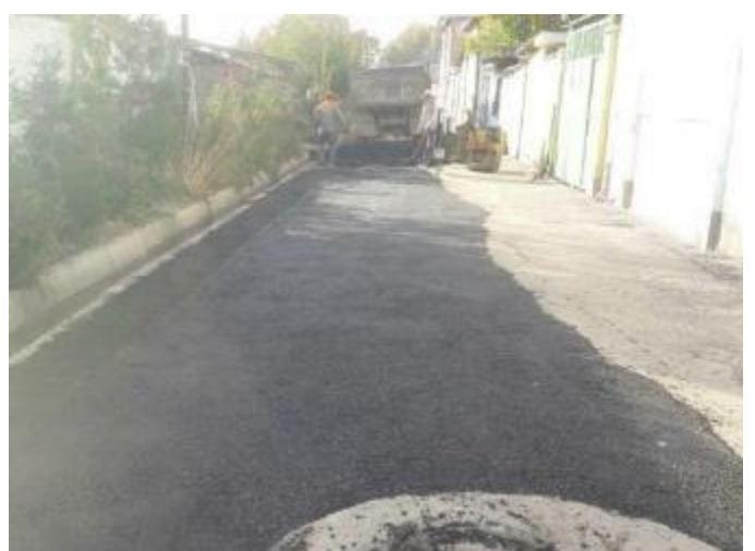
Фото 28: Восстановление асфальтобетонного покрытия, декабрь 2023 года
