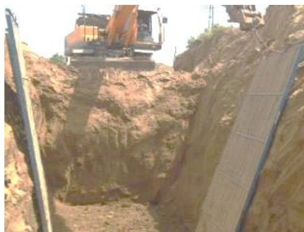
Фото 2: Монтаж крепления стенок траншеи сентябрь 2023 года
