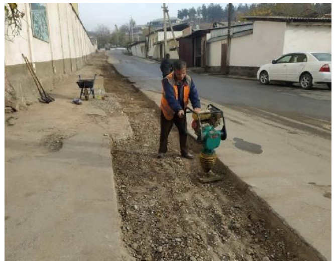
Фото 24: Работы по восстановлению асфальтового покрытия на 2 проезде улицы Айни, декабрь 2023 года
