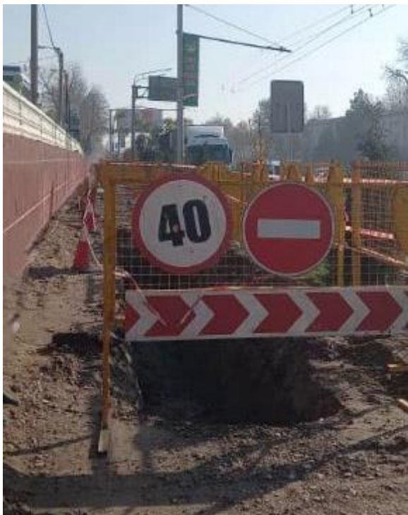
Фото 62: CW01 лот 2 -Установлены дополнительные ограждения
