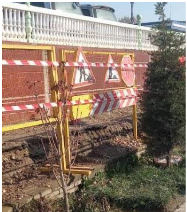
Фото 63: CW01 лот 2 -Установлены дополнительные ограждения
