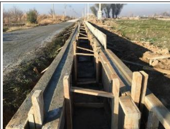
Фото 13: Бетонирование кабельных каналов, октябрь 2023 года
