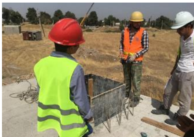
Фото 15: Монтаж опалубки люка, июль 2023 года
