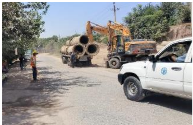
Фото 31: SW-03/2: Вывоз демонтированных старых труб, назначен сигнальщик, август 2023 года
