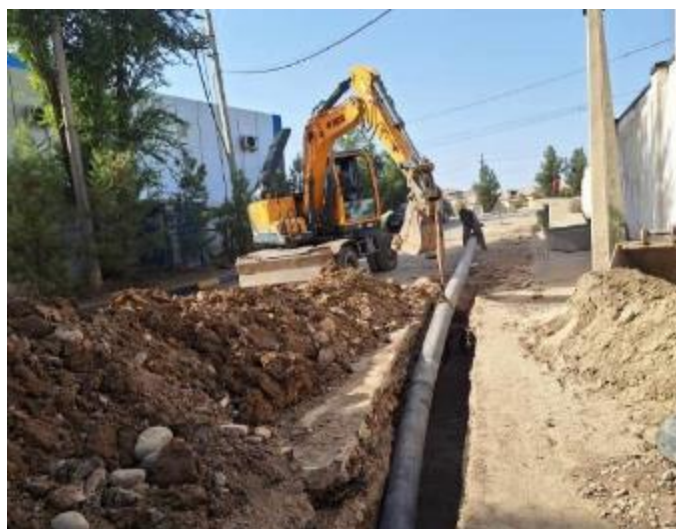
Фото 25: Монтаж труб, август 2023 года
