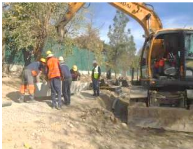
Фото 3: Монтаж желоба и гидроизоляции между люками-лазами K1-30-29, ноябрь 2023 года
