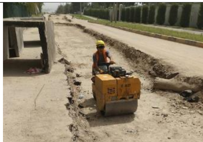
Фото 17: Уплотнение грунта, август 2023 года
