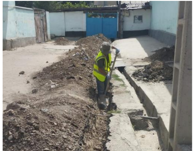
Фото 22: Ручные земляные работы, август 2023 года
