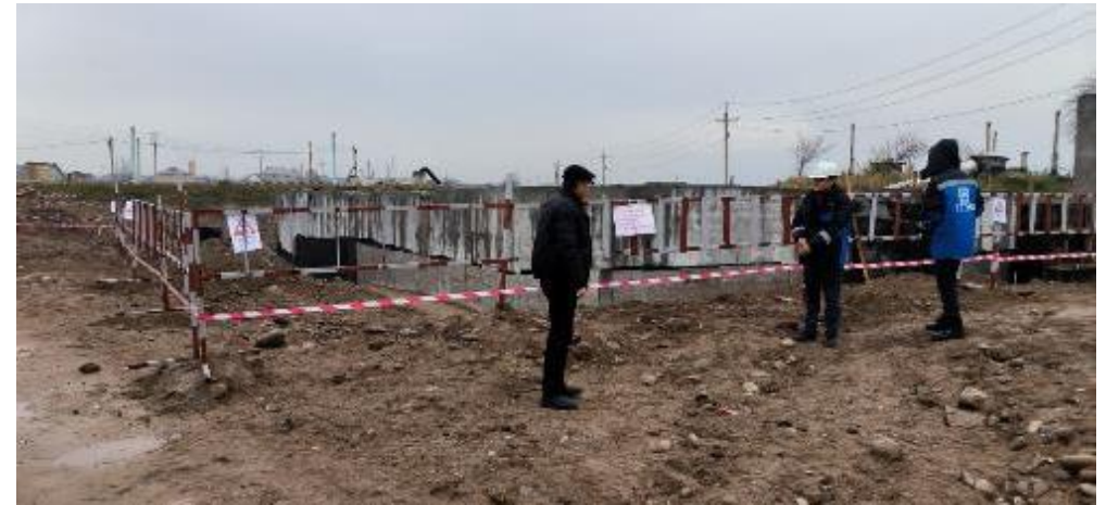
Фото 51: SW01 лот 1 - Извлеченные материалы убраны, по всей длине котлована установлены жесткие ограждения
