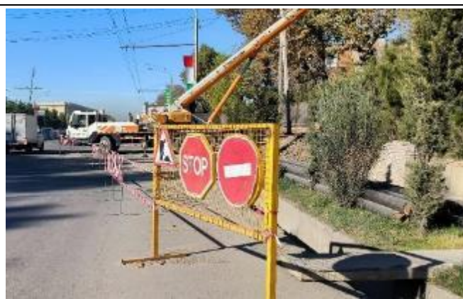
Фото 32: SW-01 Лот 2: Реализованы меры по регулированию движения при прокладке труб через улицу Айни, август 2023 года
