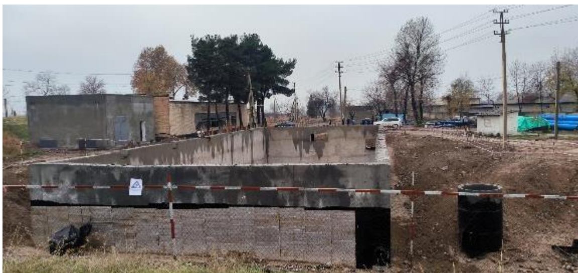
Фото 54: CW01 лот 1 - Со стороны водоема, где работа невозможна, установлена защитная сетка для предотвращения скатывания в котлован
