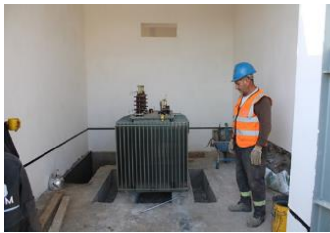
Фото 16: Монтаж трансформатора, ноябрь 2023 года
