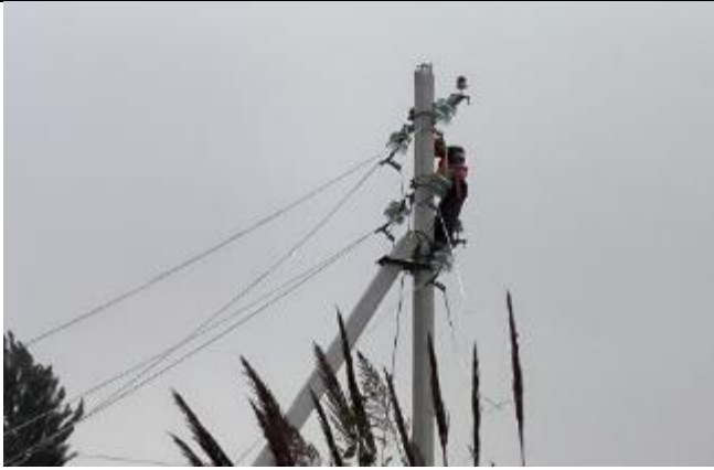
Фото 33: CW-01 Лот 1: Работа на высоте по прокладке кабеля, работник оснащен СИЗ в соответствии с планом работ на высоте, ноябрь 2023 года
