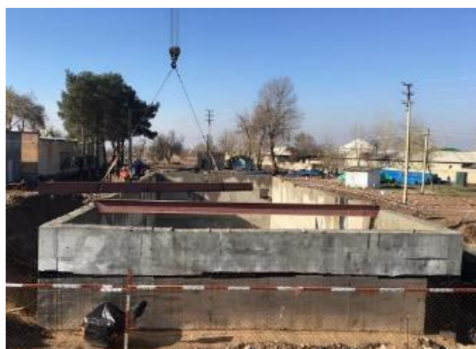
Фото 14: Монтаж главных балок насосной станции 2-го подъема, декабрь 2023 года
