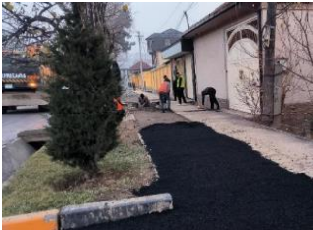
Фото 42: Рабочий процесс по восстановлению тротуаров и обеспечению беспрепятственного доступа к домам.
