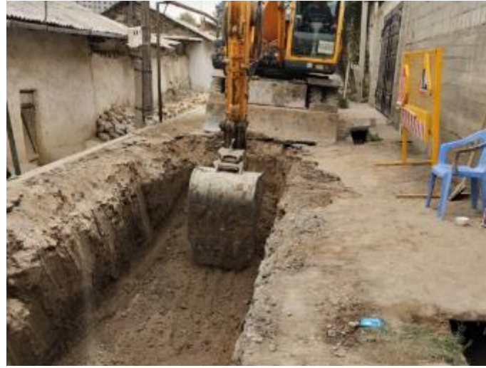
Фото 20: Земляные работы, ноябрь 2023 года
