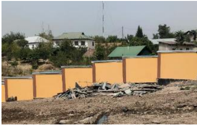
Фото 35: Некоторые строительные отходы наблюдались на стройплощадке, 13 сентября 2023 года
