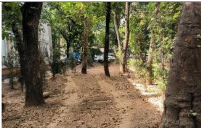
Фото 29: SW-04 Лот 1: Территория восстановлена после прокладки труб, июль 2023 года
