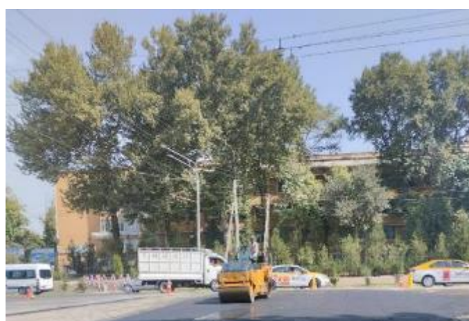
Фото 18: Укладка асфальта на дороге Айни - участок № 3, август 2023 года
