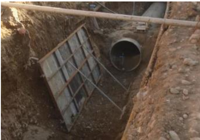
Фото 7: Монтаж крепления стенок траншеи, ноябрь 2023 года
