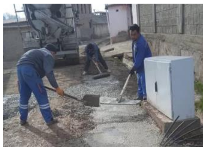
Фото 12: Восстановление рабочих площадок, ноябрь 2023 года
