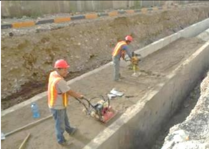
Фото 5: Уплотнение грунта, июль 2023 года
