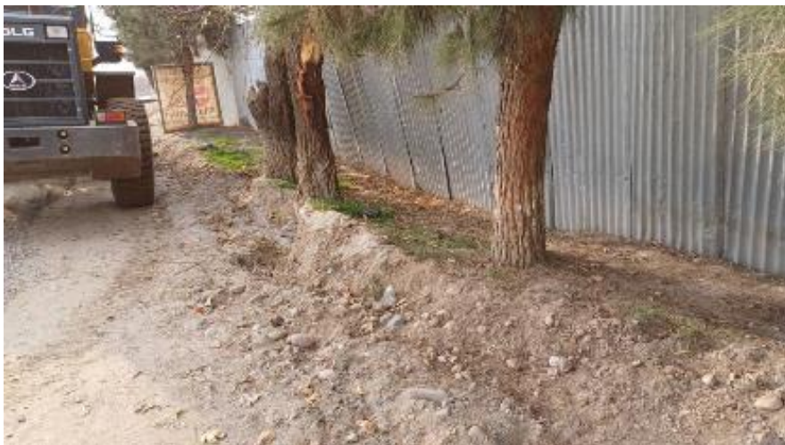
Фото 59: SW03/2 Стройплощадка очищена от материалов и отходов
