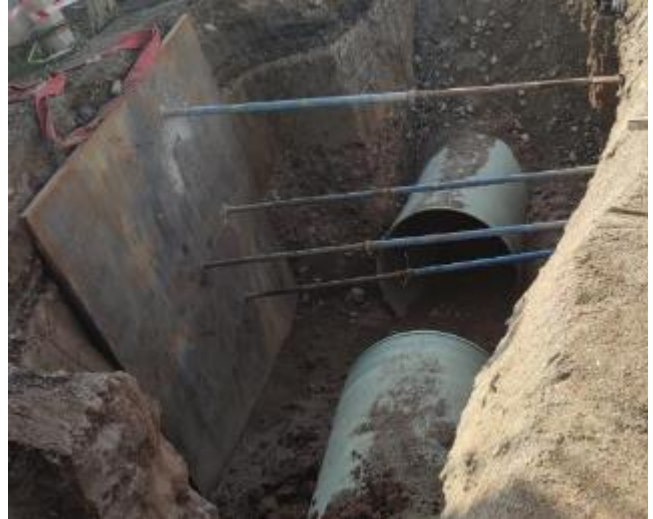
Фото 65: SW01 лот 2 - Установка ограждения траншеи
