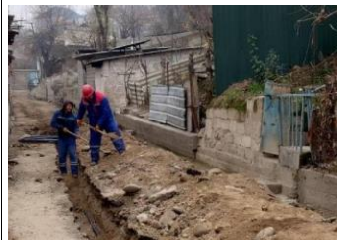
Фото 11: Ручная засыпка траншей, ноябрь 2023 года
