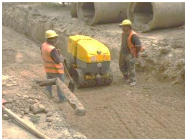
Фото 1: Уплотнение грунта на K36, июль 2023 года
