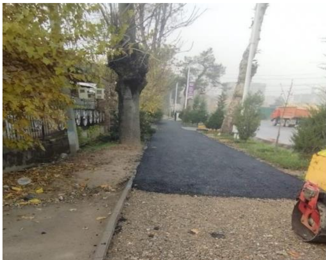
Фото 23: Работы по восстановлению покрытия на улице Н.Мухаммада (А-1), декабрь 2023 года
