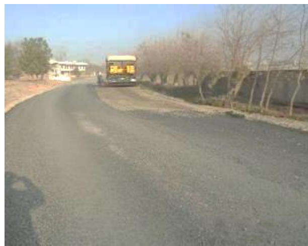
Фото 4: Восстановление дорог, декабрь 2022 года
