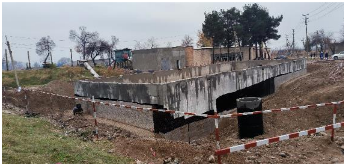
Фото 53: CW01 лот 1 - Со стороны водоема, где работа невозможна, установлена защитная сетка для предотвращения скатывания в котлован
