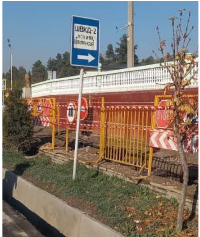
Фото 61: CW01 лот 2 -Установлены дополнительные ограждения
