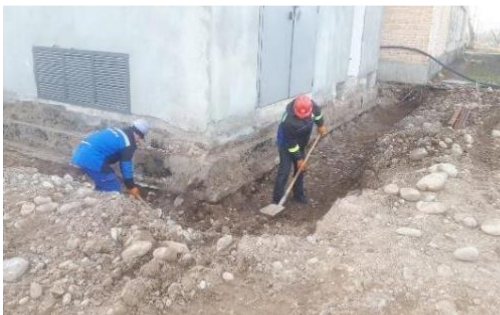
Фото 55: CW01 лот 1 - Работники, оснащенные СИЗ и носящие его
