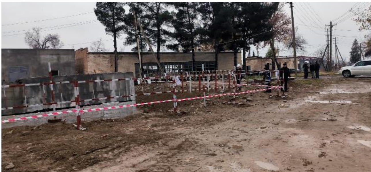
Фото 52: CW01 лот 1 - По всей длине котлована установлены жесткие ограждения
