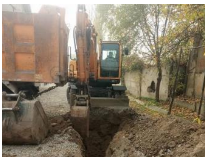
Фото 27: Земляные работы, ноябрь 2023 года
