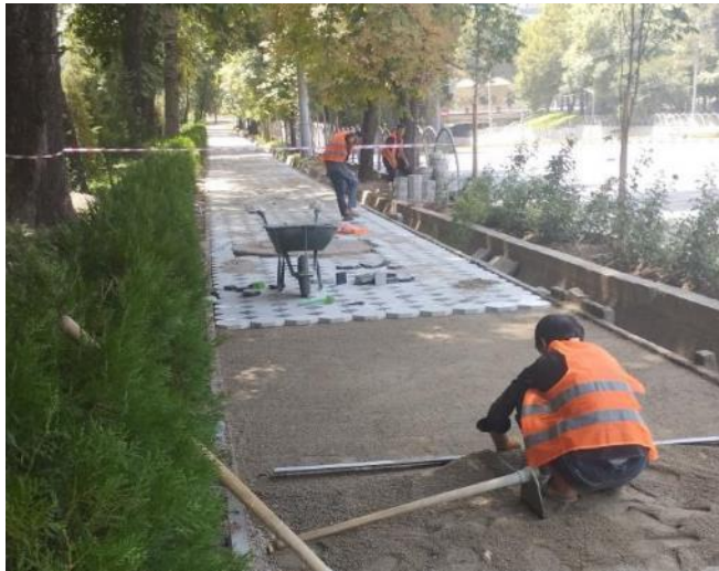
Фото 21: Восстановление рабочих площадок, июль 2023 года
