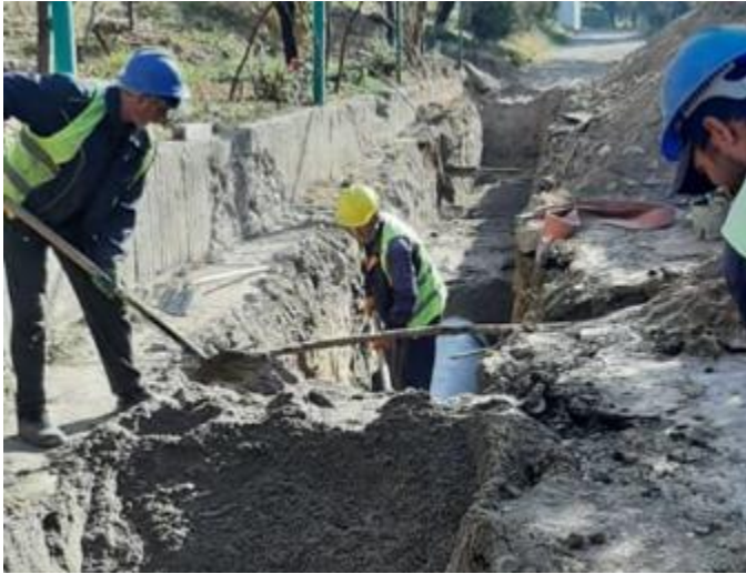
Фото 19: Ручная засыпка траншей под трубы, ноябрь 2023 года
