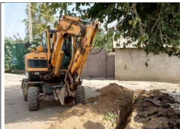
Фото 9: Раскопки траншей для укладки труб, август 2023 года
